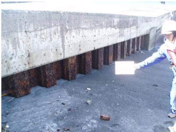
矢板式突堤の劣化(鋼矢板の腐食)状況
