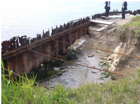
矢板式岸壁の劣化(腐食・吸出し)状況
