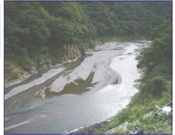
ダム・貯水池は長い期間の洪水調節・利水補給の運用の結果、上流からの土砂も貯めてしまいます。ダム堆砂に関するさまざまな問題を考える際、説明性の高い精緻な資料が必要となります。これに応えるため、ダム堆砂シミュレーションによる予測をご提案します。
