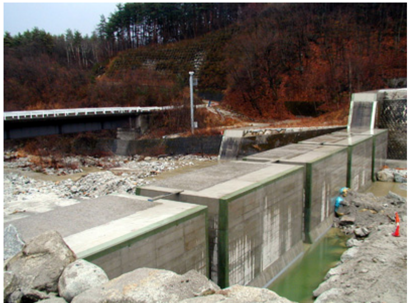
関東地整富士川砂防管内 尾白川第3砂防ダムえん堤スリット化工事中
