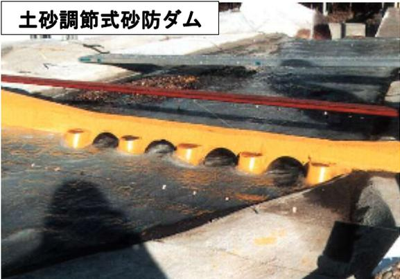
土砂調節式砂防ダムは、ダムの水通し部に単一または複数の切欠けを入れたり、堤体に暗渠を設けたりして、流出する土砂の粒径を調節する機能を持ったダムです。
